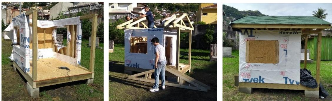
Figura 9: Execução da casinha no canteiro conforme projeto. Fonte: Elaborado pelos autores.
