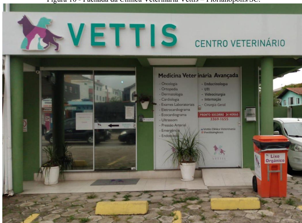
Figura 10 - Fachada da Clínica Veterinária Vettis – Florianópolis/SC.
