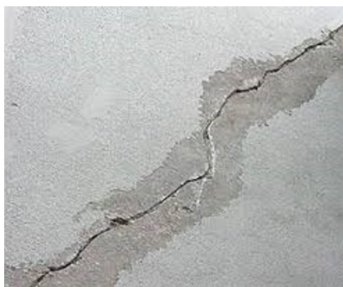
Figura 03 - Fissura geométrica
