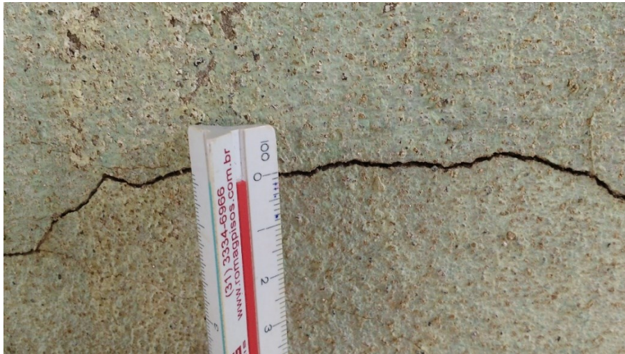
Figura 05 - Trinca
