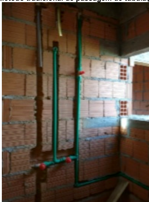
Figura 9- Método tradicional de passagem de tubulação
