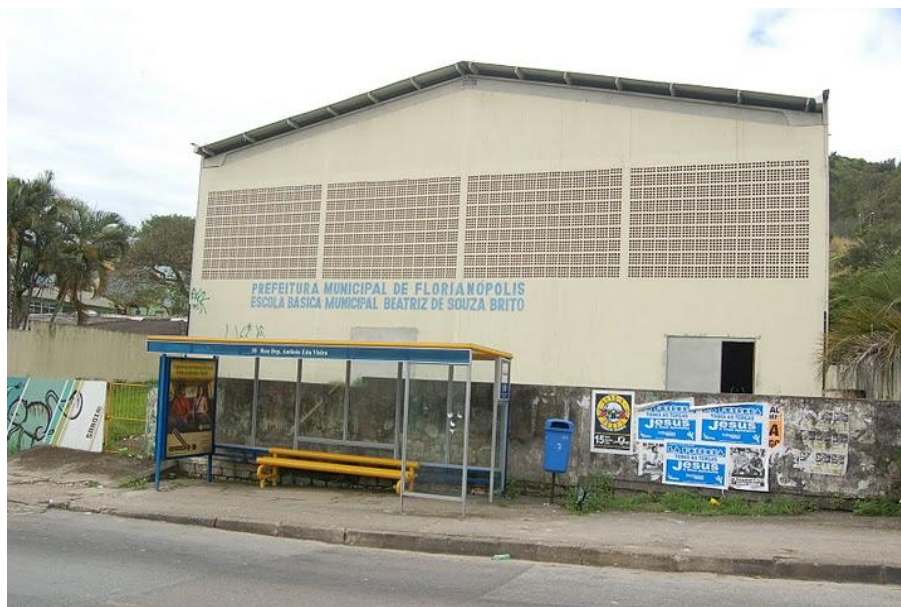
Figura 1 - Foto da fachada da Escola Beatriz de Souza Britto
