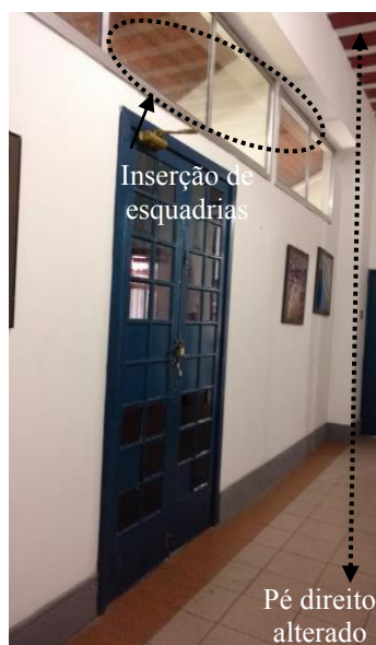
Figura 9: Recepção- prédio principal. Fonte: Elaborado pelas autoras, 2016.
