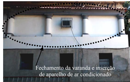
Figura 8: Sede Administrativa da Fundação RIOZOO. Prédio principal, fachada posterior. Fonte: Elaborado pelas autoras, 2016.
