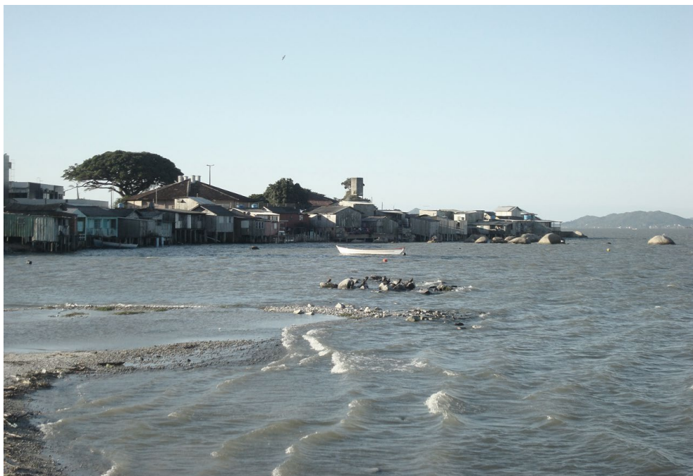
Imagem 3: Ocupação informal em área de risco, em Florianópolis-SC. Fonte: Acervo pessoal (2011).
