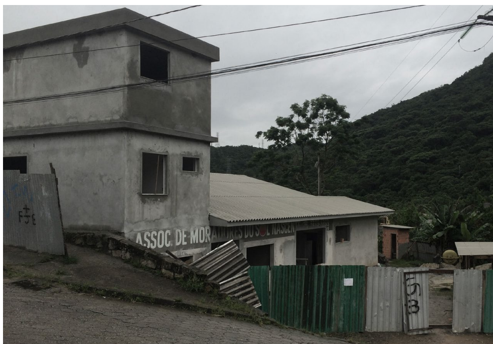
Imagem 19: Sede da AMSOL, em atual reforma. Fonte: Acervo pessoal (2016).
