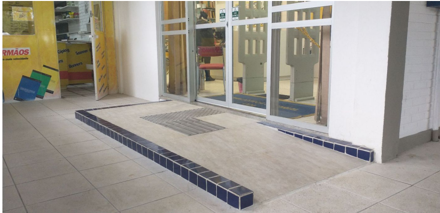
Figura 2: Rampa construída na entrada da BSCCA.
