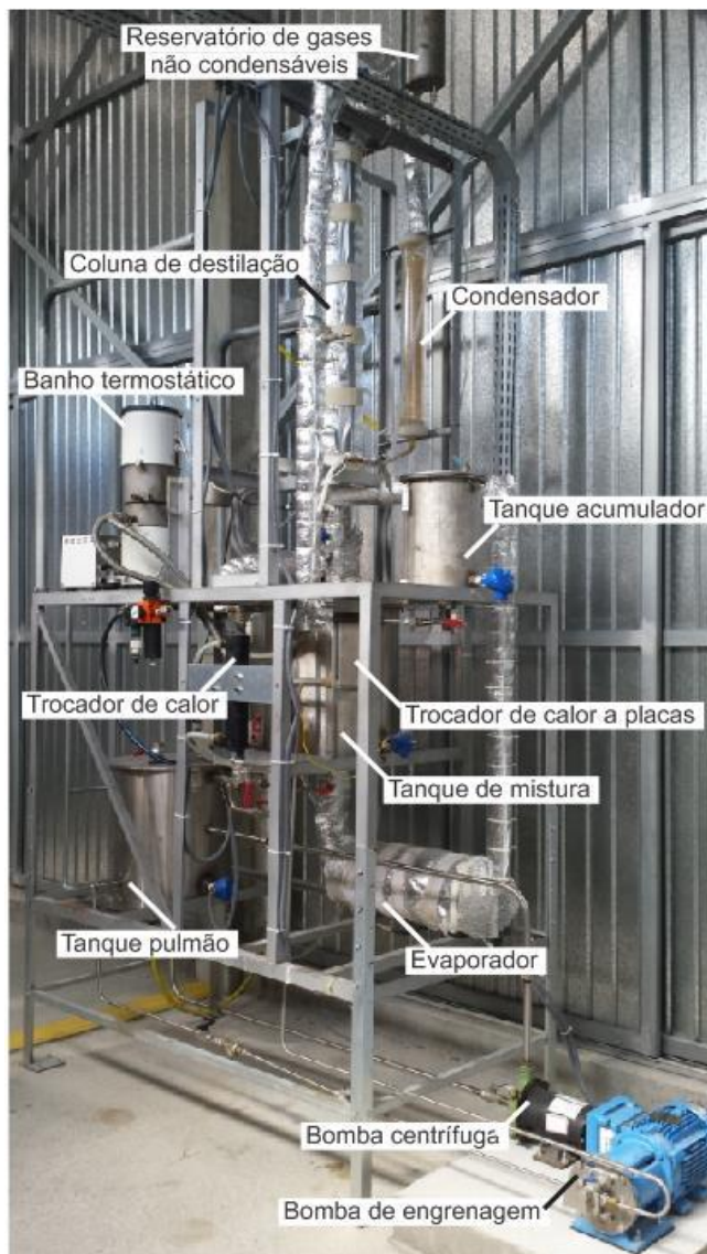
Figura 22 - Fotografia da unidade de destilação por filme descendente assistida por termossifão bifásico
