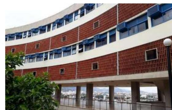
Com o recente restauro, as antigas janelas de madeira foram trocadas por esquadrias de alumínio pintadas de azul. Foram incorporados ao projeto espaços para instalação de ar condicionado, já que parte dos moradores haviam instalado este equipamento.
