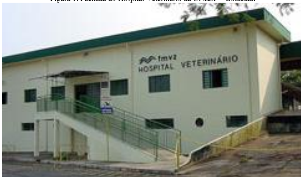
Figura 1. Fachada do Hospital Veterinário da UNESP – Botucatu.
