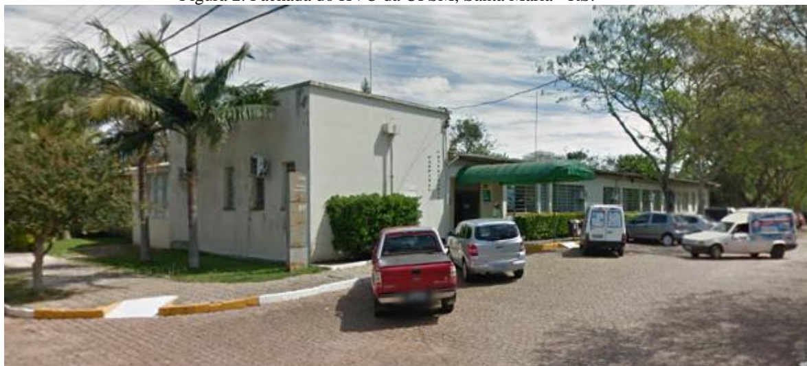
Figura 2. Fachada do HVU da UFSM, Santa Maria - RS.
