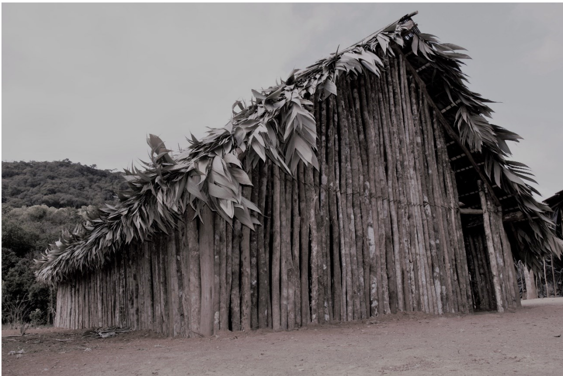
Imagem 2: Opy, casa de reza em construção. Fonte: Arquivo pessoal, julho de 2017.
