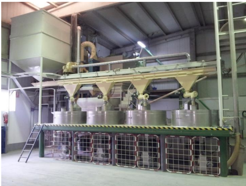
Figura 10: Instalación de moenda.
