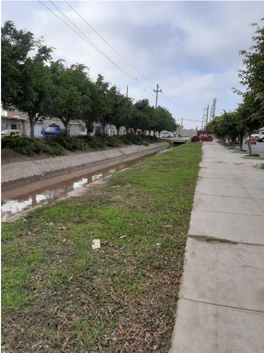
Ilustración 68: Canal ubicado en la Av. Fitzcarrald y Calle Mesones Muro.
