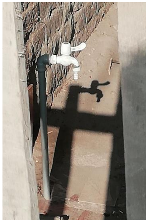
Figura 32. Conexiones clandestinas
