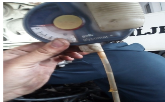
Slika 4: Kontrolom vrste i kvaliteta rashladne tečnosti u motoru, došlo se do zaključka da se u njemu nalazi obična voda
