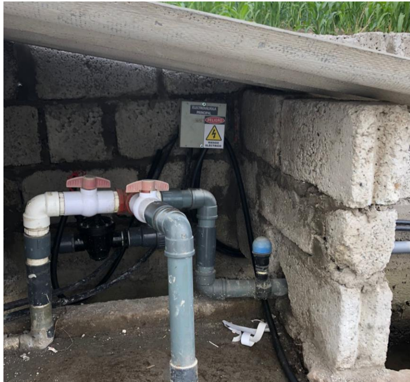
Figura 5.2 Instalación de electroválvula principal
