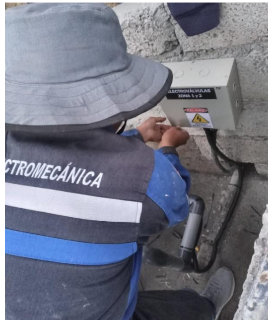
Empotrado de la caja de conexiones eléctricas.
