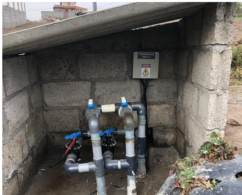
Figura 5.3 Instalación de electroválvula zona 1 y 2
