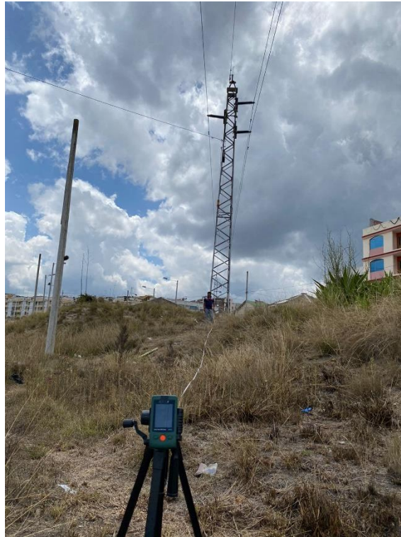
Figura D.9. Colocación del equipo EMF 450 METER Torre E-0268.
