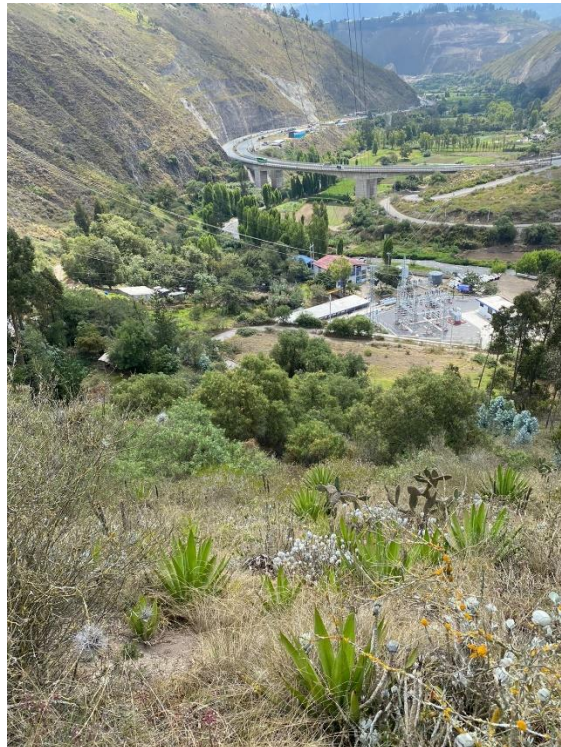
Figura D.4. Elementos propios de la zona vano atrás Torre E-1075.
