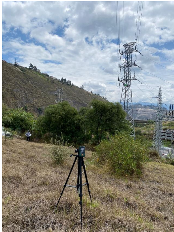
Figura D.6. Toma de datos vano atrás Estructura E-1075.
