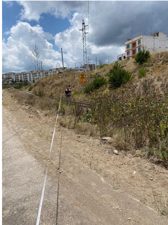
Figura D.11. Aspectos geográficos vano atrás Torre E-0268.
