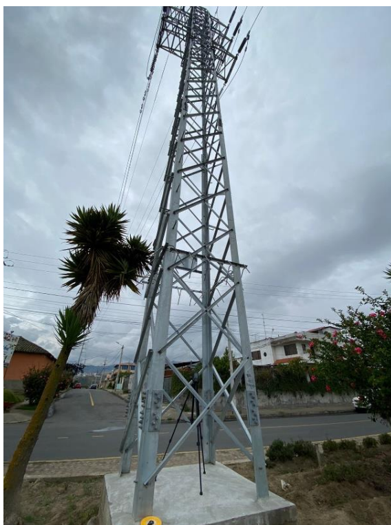
Figura D.1. Toma de datos dentro de la Torre E-1075.
