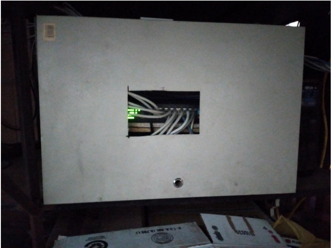
Figura 10.13 Estructura de switch administrable.
