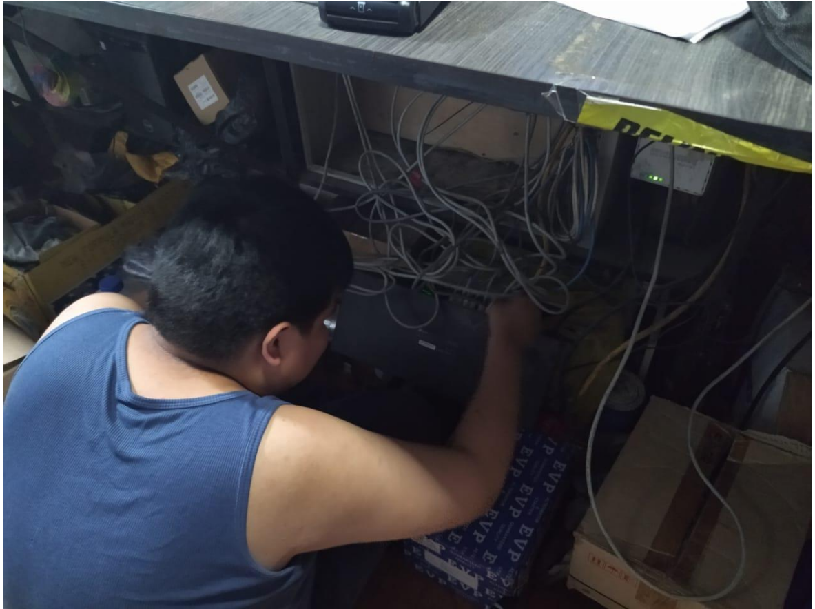
Figura 10.2 Comprobación del estado del cableado.
