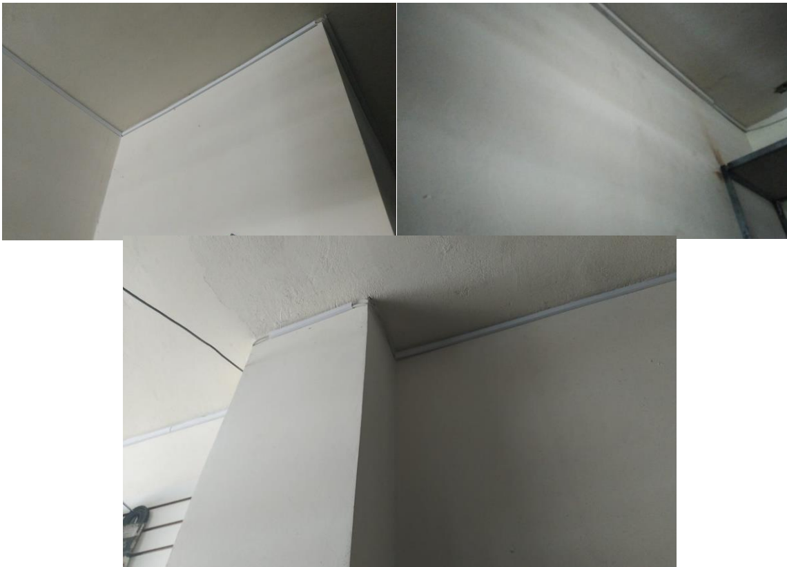
Figura 10.8 Canaletas por donde se pasa el cableado.
