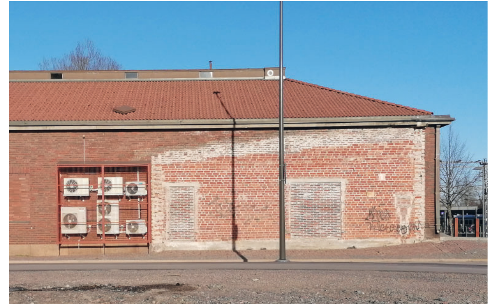
Kuva 46, 47. Puretun rakennussiiven jäljet.
