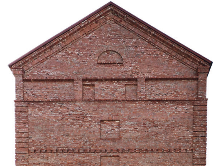
Kuva 35. Kaakkoisjulkisivu ennen purkua ja uudelleen muurattuna.
