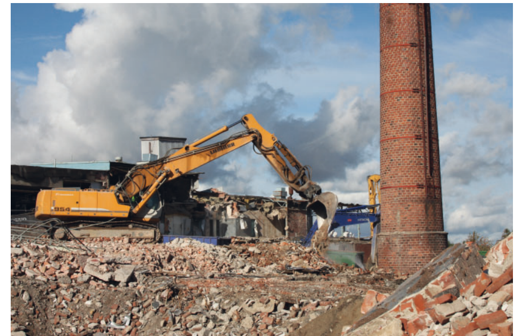
Kuva 21. Atrian tuotantolaitoksen purku.
