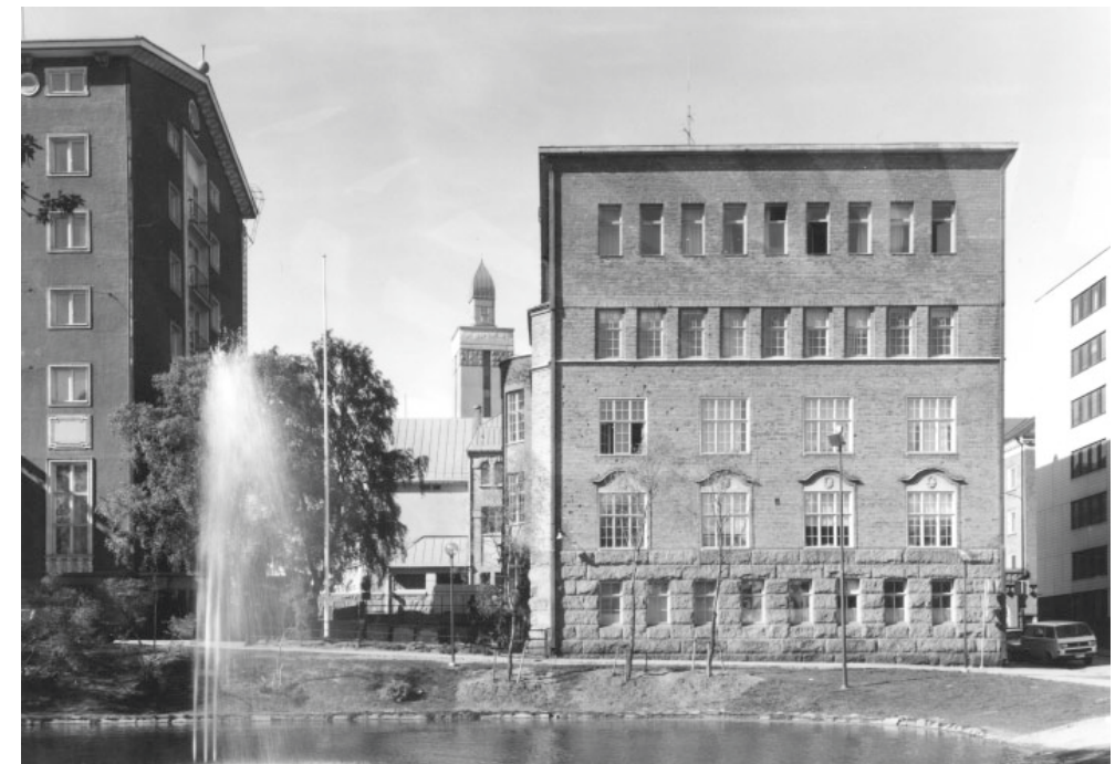
Kuva 42. Tampereen kauppaoppilaitos korotuksen jälkeen. Tiilirakennusta on luontevaa jatkaa tiilellä. Uuden ja vanhan osan välistä kontrastia on korostettu arkkitehtonisin keinoin. Korotuksen suunnitteli Bertel Strömmer. Kuva: Kari Hakli, 1990
