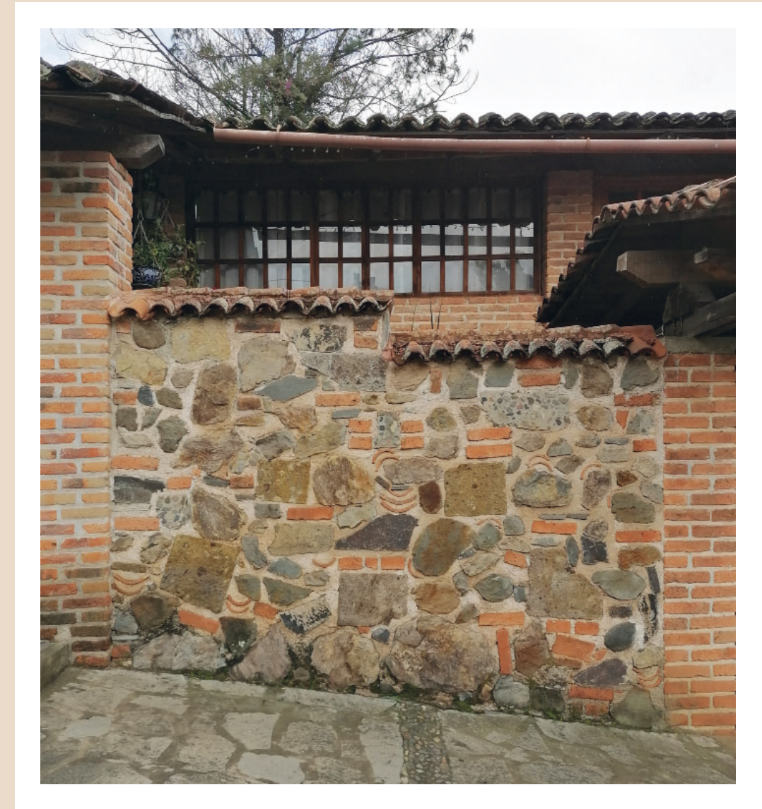
Kuva 43. Tiilen uudelleen käyttöä Meksikon Tapalpassa.
