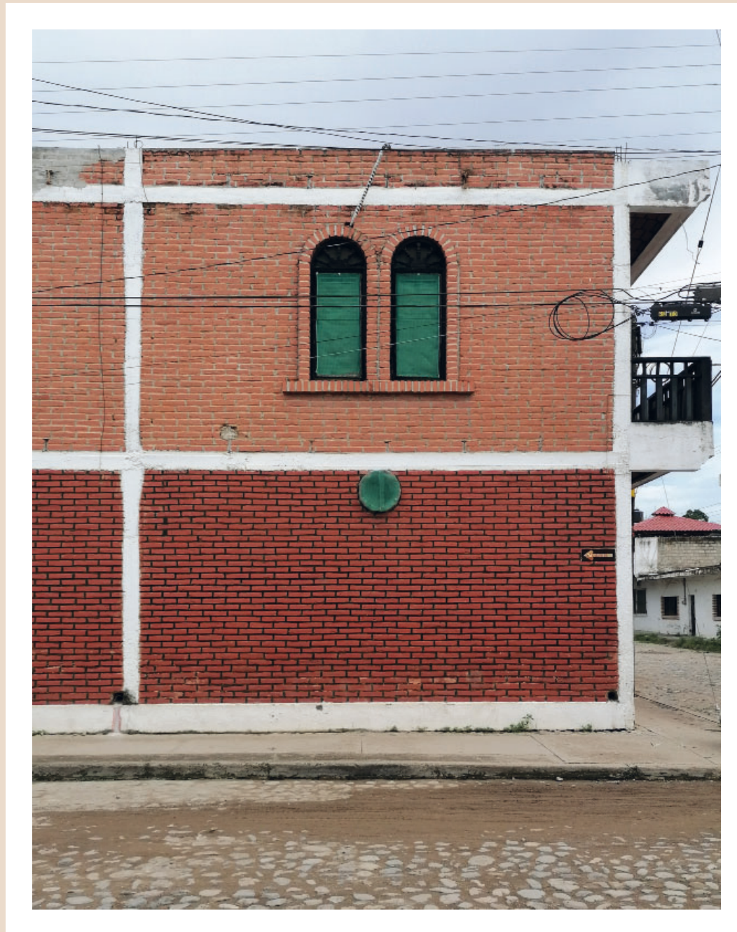
Kuva 44. Tiiliseinä Meksikon La Peñita de Jaltembassa.
