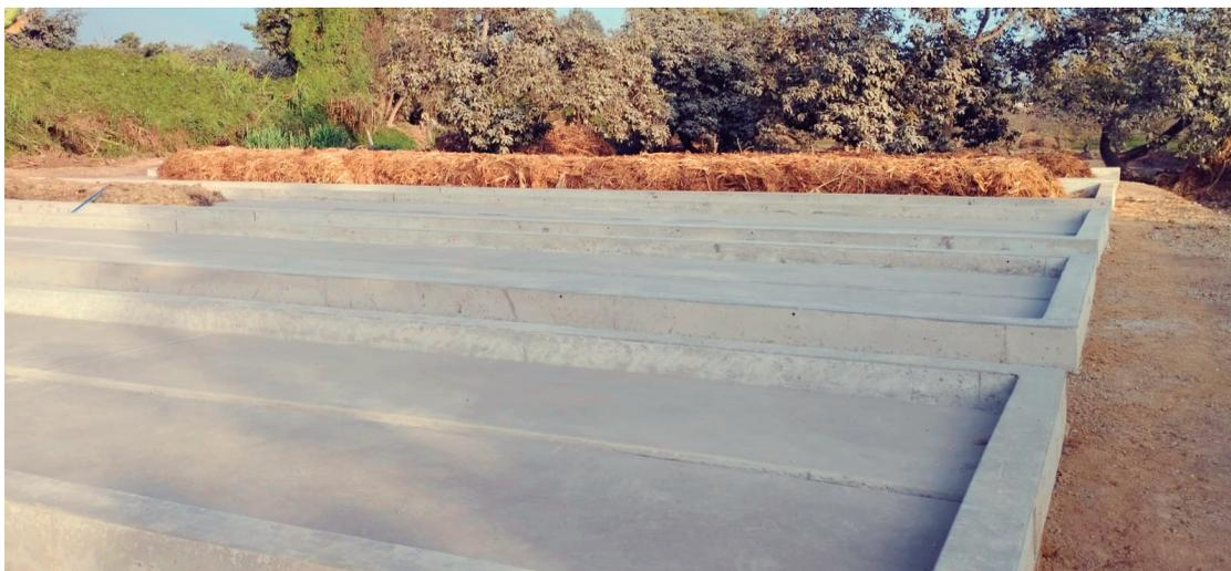
**Figura 1.** Pilas de concreto para procesamiento en compostaje
