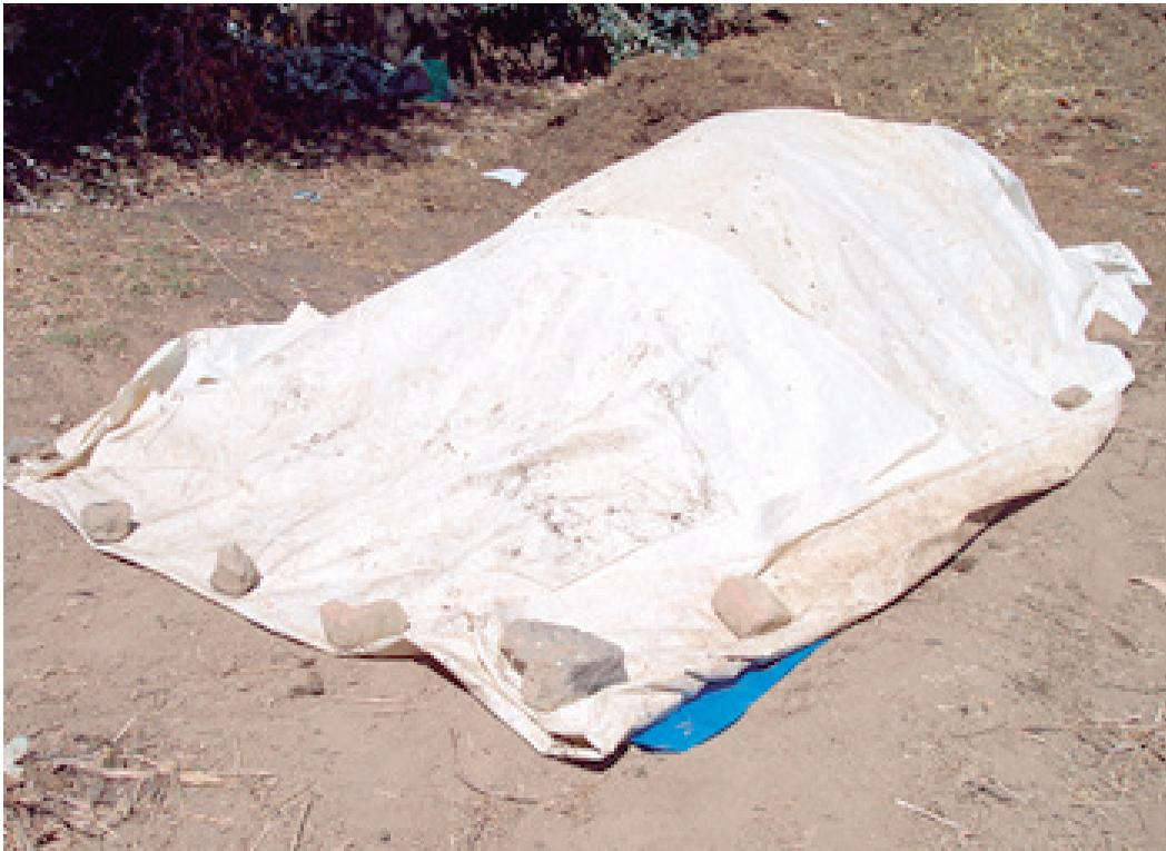
**Figura 40.** Cubierta de la mezcla con sacos
