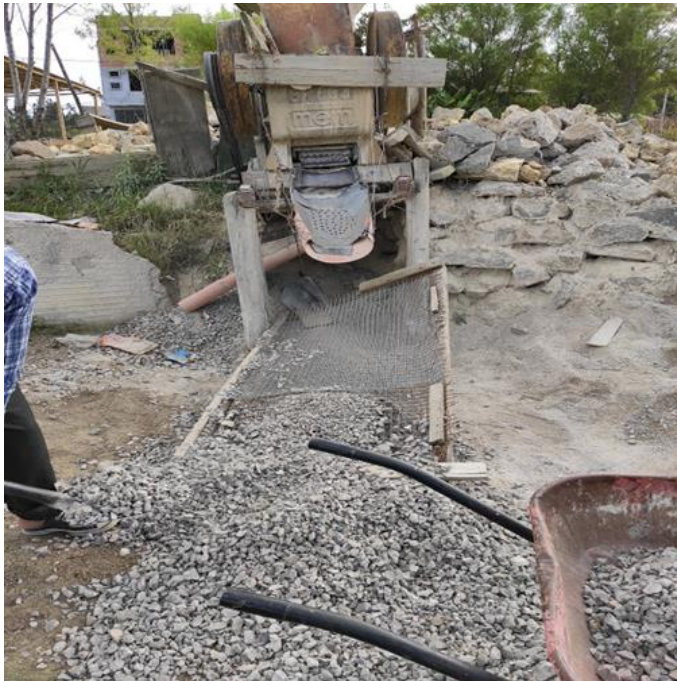
Foto N° 27: Obtención de agregado grueso reciclado.
