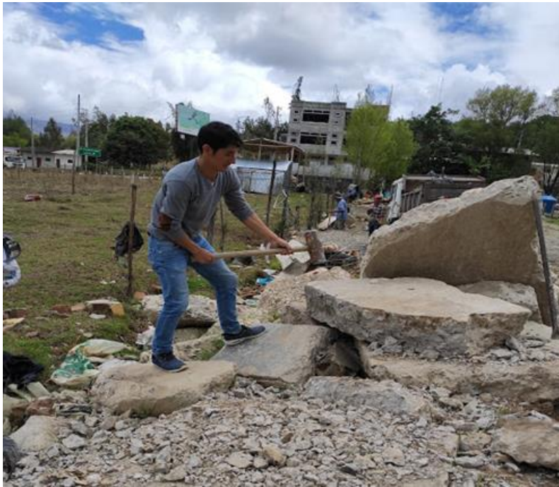
Foto N° 25: Rompiendo el concreto reciclado para que se pueda procesar en la trituradora.
