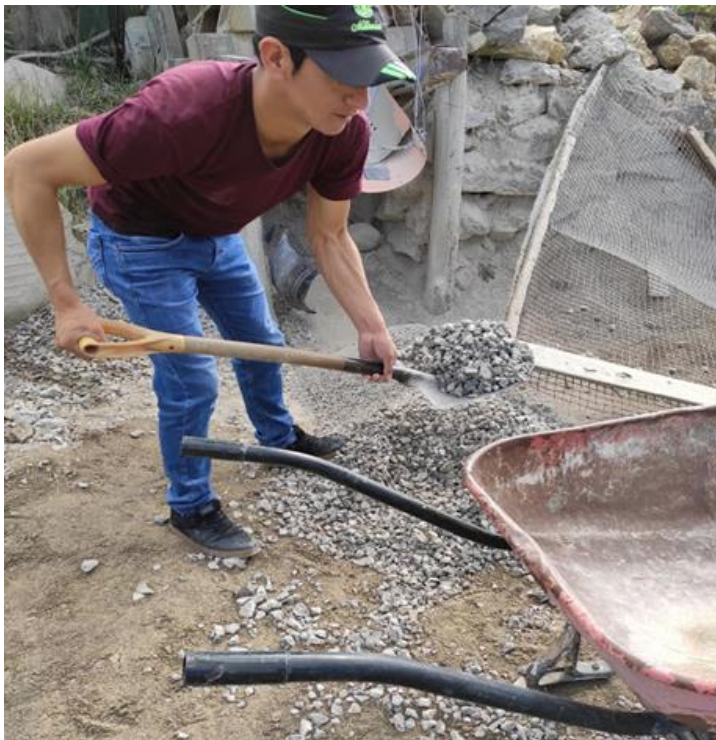
Foto N° 28: Tamizado y traslado de material reciclado al laboratorio de materiales.
