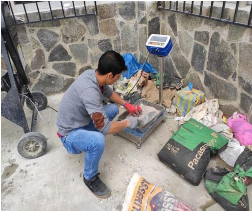
Foto N° 46: Pesado de materiales para la mezcla de concreto.
