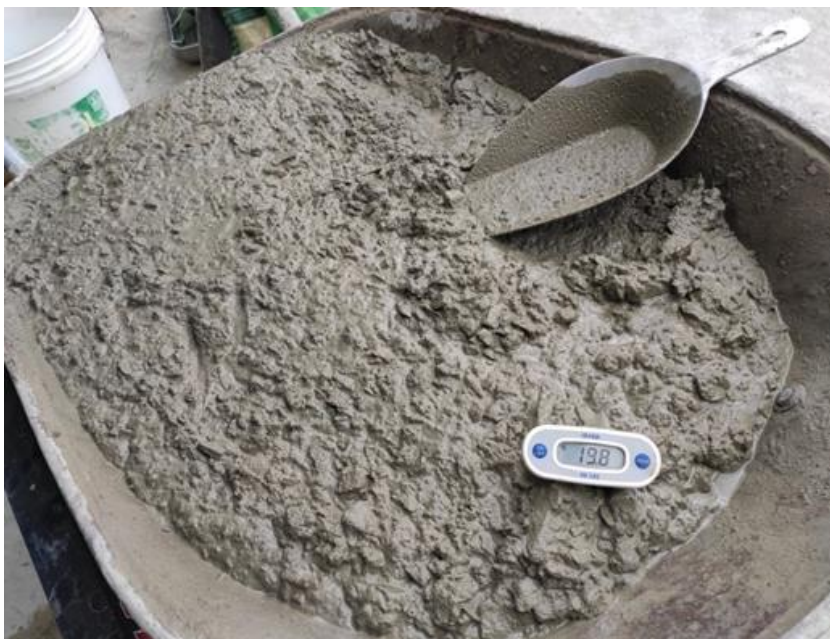
Foto N° 48: Medición de temperatura al concreto fresco.
