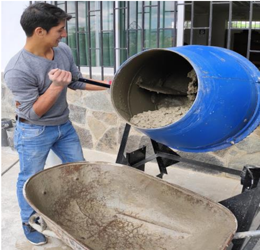
Foto N° 47: Mezclado de concreto.
