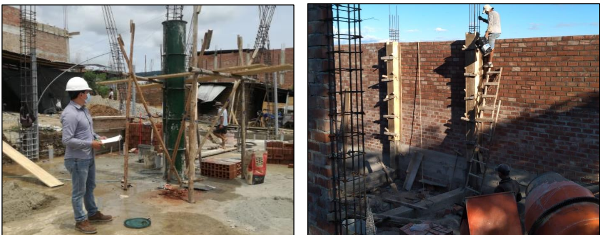
Figura 6. Proceso de colocación de concreto en columnas.
