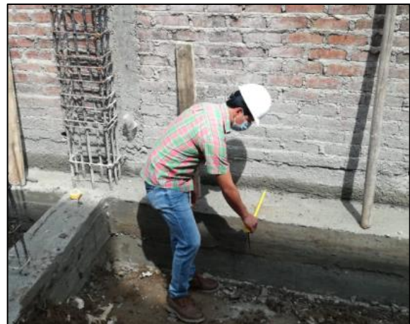
Figura 3. Verificación de secciones en viga de cimentación en obras tipo “C”
