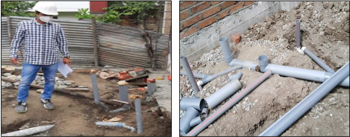
Figura 4. Instalaciones sanitarias en obras construidas de manera tradicional y con la filosofía Lean Construction.
