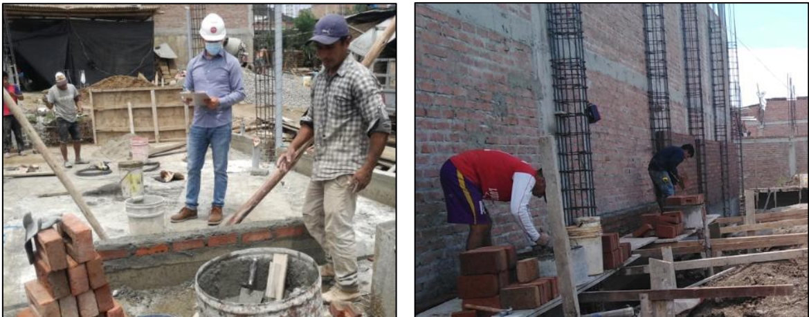
Figura 5. Asentado de ladrillo con aparejo de sogá en obras construidas de manera tradicional y con la filosofía Lean Construction.
