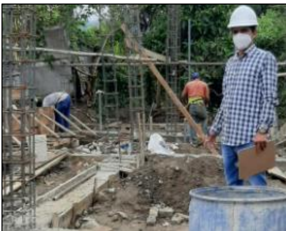
Figura 3. Verificación de secciones en viga de cimentación en obras tipo “C”
