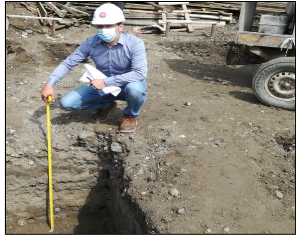
Figura 1. Verificación de profundidad de excavación en obras construidas de manera tradicional y con la filosofía Lean Construction.
