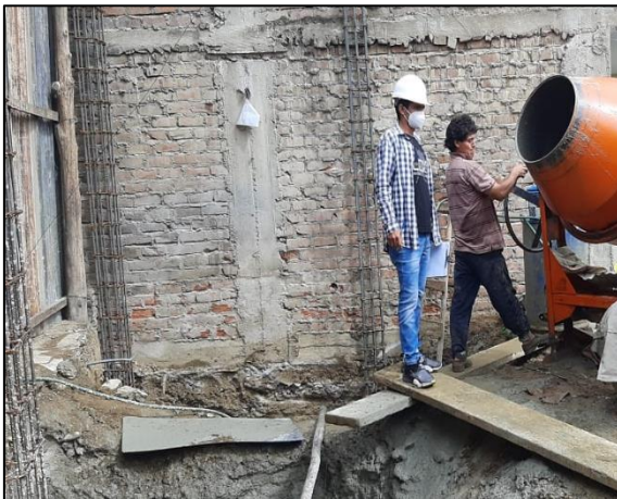
Figura 2. Llenado de concreto en zapatas en obras construidas de manera tradicional y con la filosofía Lean Construction.
