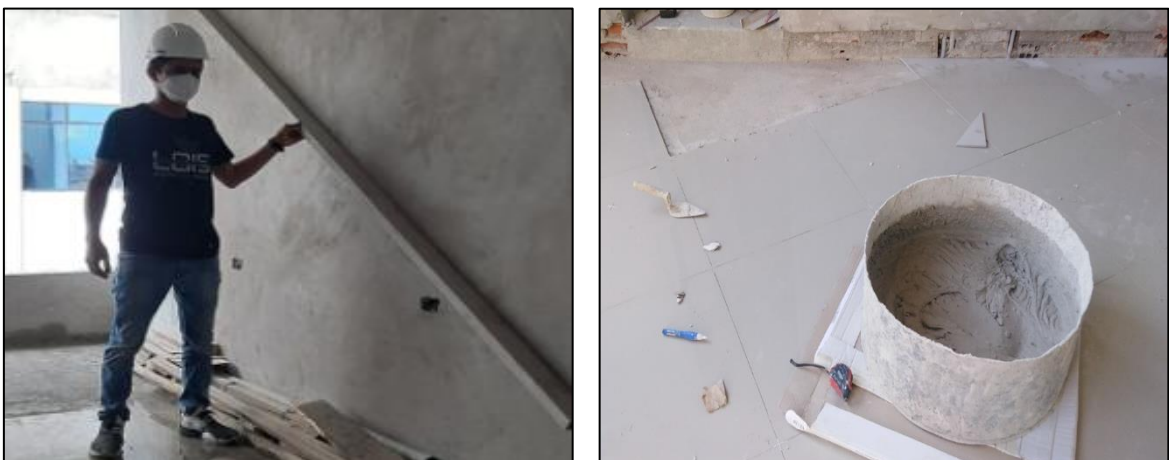
Figura 9. Verificación de tarrajeo y asentado de porcelanato de 60cmx60cm.
