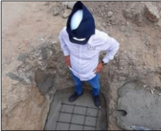
Figura 1. Verificación de profundidad de excavación en obras construidas de manera tradicional y con la filosofía Lean Construction.
