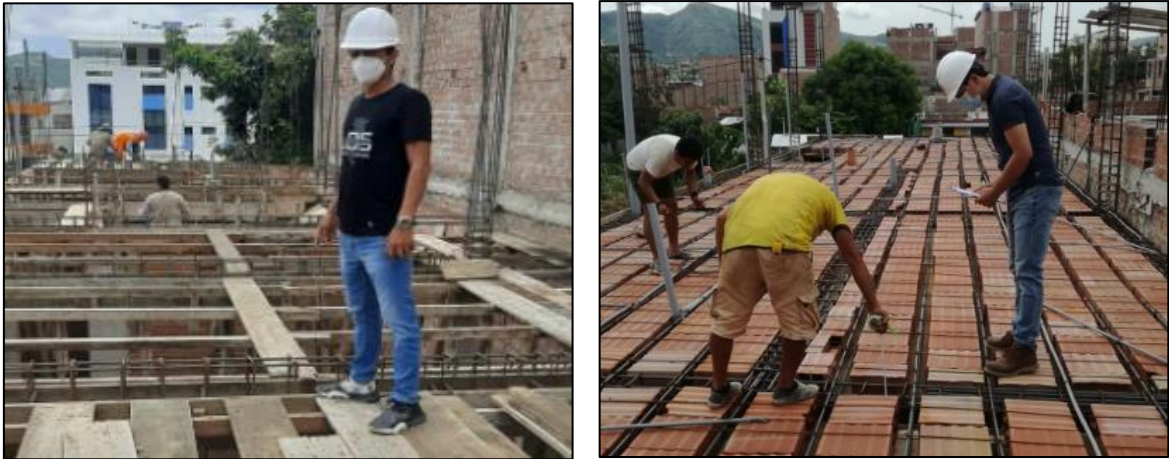
Figura 7. Encofrado de losa aligerada y verificación de peraltes en vigas
