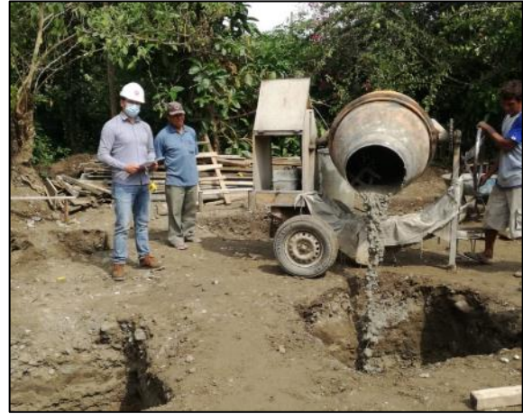
Figura 2. Llenado de concreto en zapatas en obras construidas de manera tradicional y con la filosofía Lean Construction.
