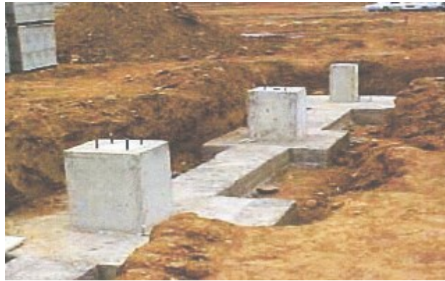
Imagen 133: Detalles de zapatas conectadas.
