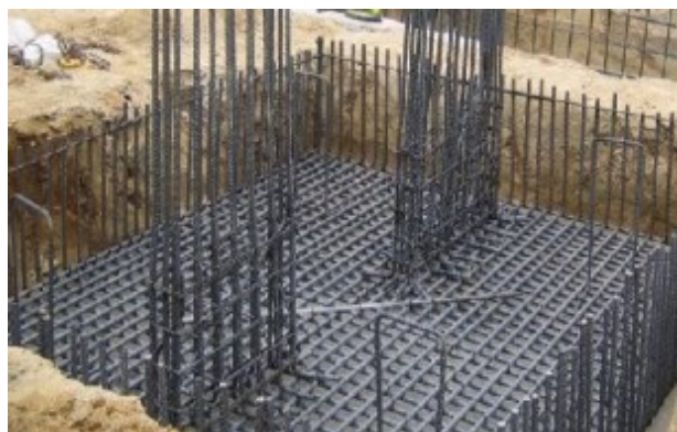
Imagen 132: Detalles de zapatas combinadas.
