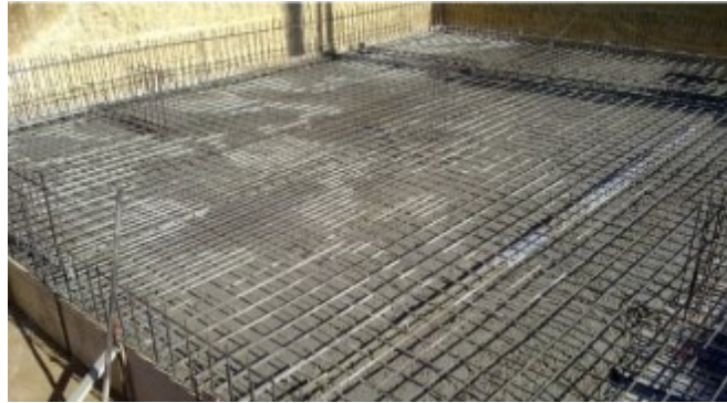
Imagen 135: Detalles de Platea de Cimentación.
