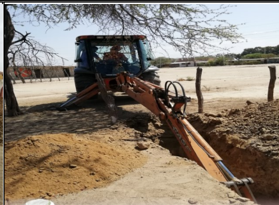
FOTO N°12: Trazo y Excavación de Calicatas con retroexcavadora C-01
