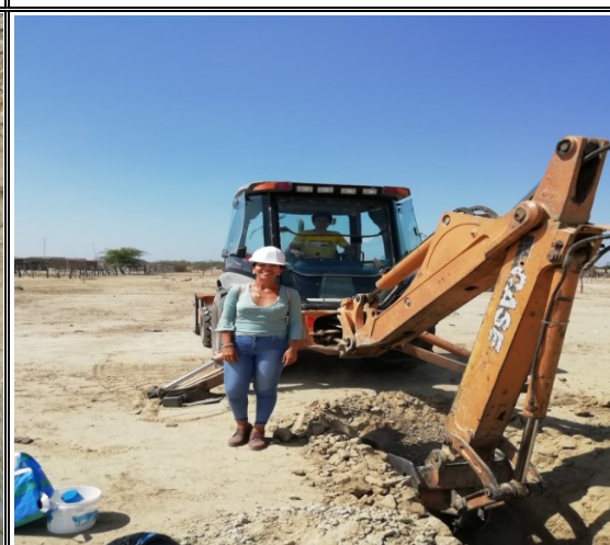
FOTO N°16: Extracción de muestras C-20
