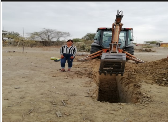
FOTO N°11: Trazo y Excavación de Calicatas para EMS
