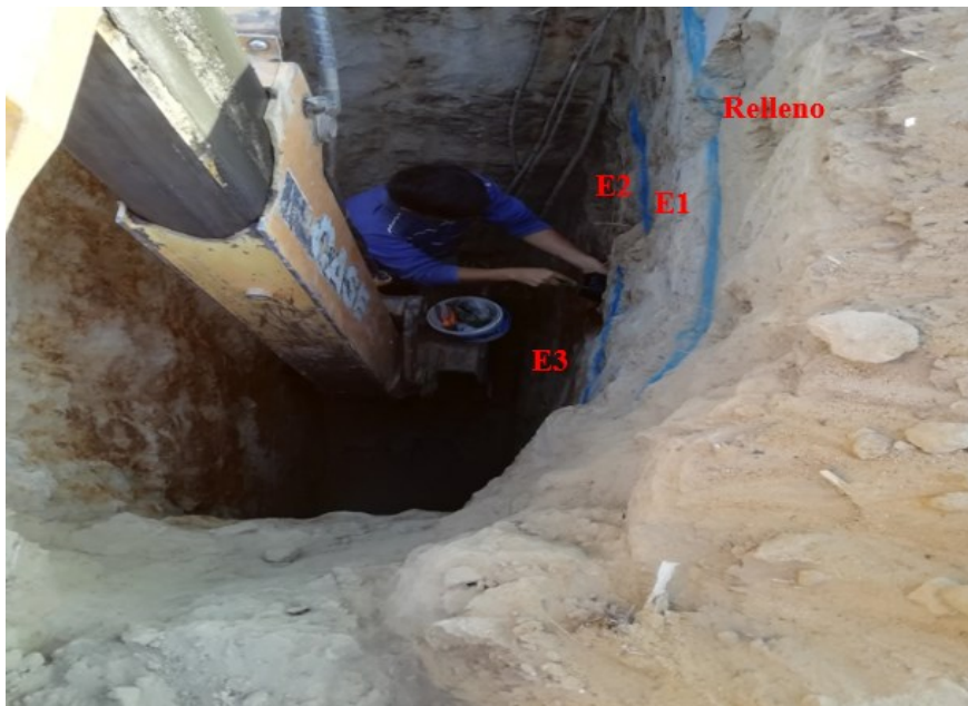
Imagen 16: Identificación de estratos después de la excavación.
