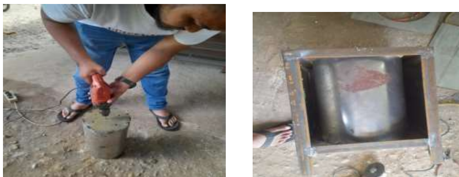
Gambar 6. Pelubangan Tabung Bagian Dalam dan Pemasangan Tabung ke dalam Rangka
