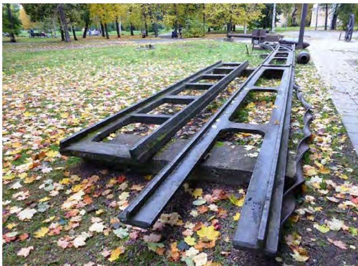
Рис. 1. Конструкция верхнего строения пути «чугунный колёсовод». [Электронный ресурс]: <https://umcздт.ru/news/demohtml/80.html>. Доступ 11.06.2021.
