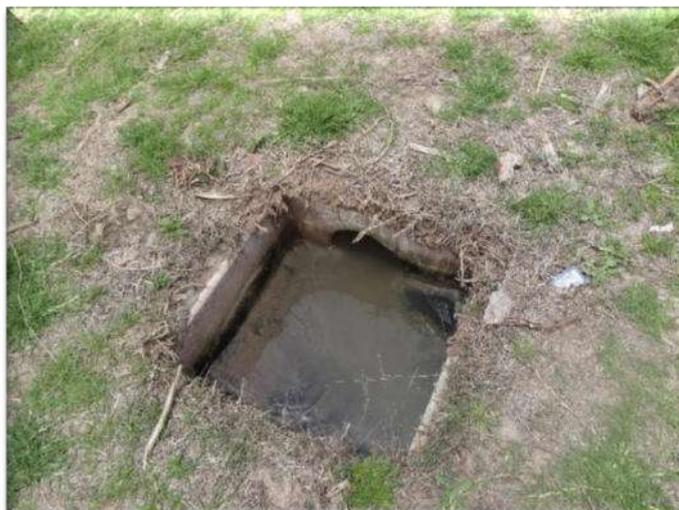
**Cámara de Ingreso.** - Esta estructura de concreto se encuentra al inicio de la planta de tratamiento y cumple una función de inspección y limpieza.
