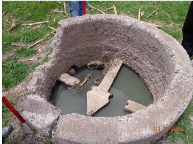
*Se puede apreciar en la foto la deficiente distribución que se realiza para las lagunas existentes ocasionando que una se cargue mas que la otra, se debe tomar en cuenta que las lagunas tienen diferentes áreas por tanto se debe proporcionar su caudal de ingreso.*
