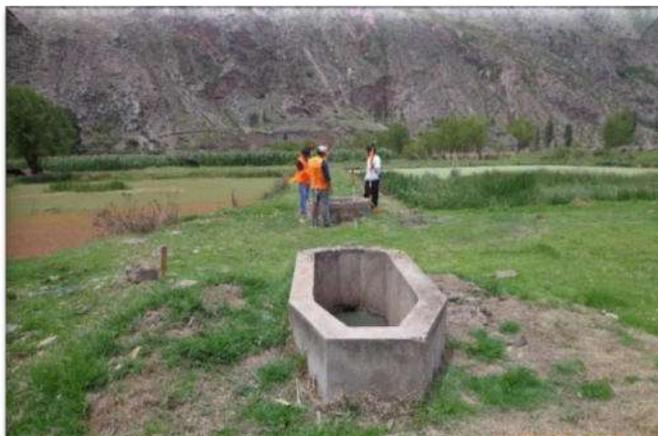
Como se observa en la foto, la estructura no está bien diseñada y el estado de conservación es regular. Prácticamente este desarenador solo es un paso de las aguas residuales, el cual intercepta el mínimo de arenas. No se tiene una válvula de purga.
