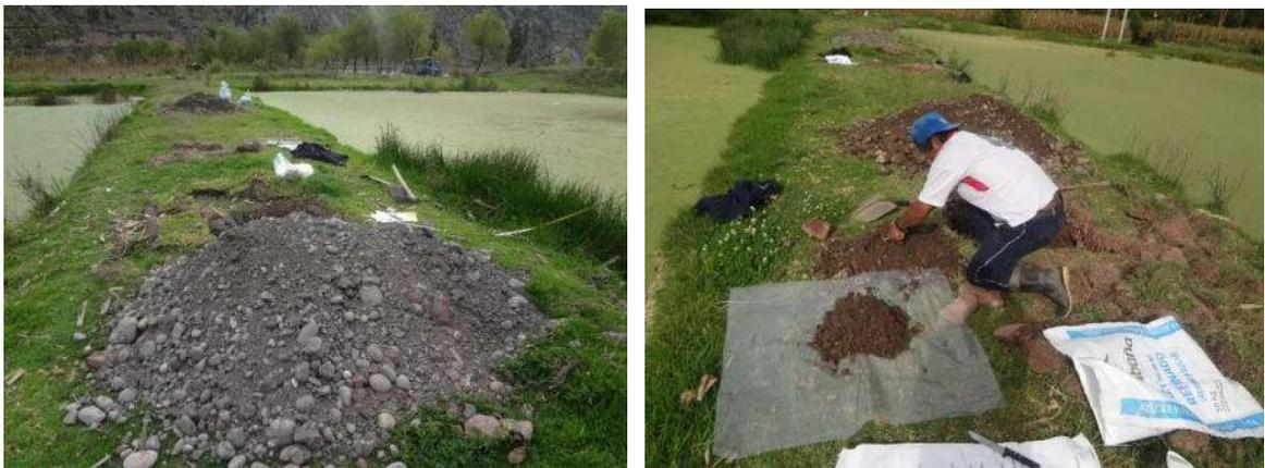
Se muestra la extracción del material en la calicata entre ambas lagunas existentes.
