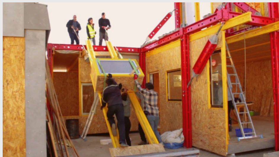
Proceso de montaje de las cerchas por parte de los vecinos de la Cañada Real. Recetas Urbanas, 2021.
