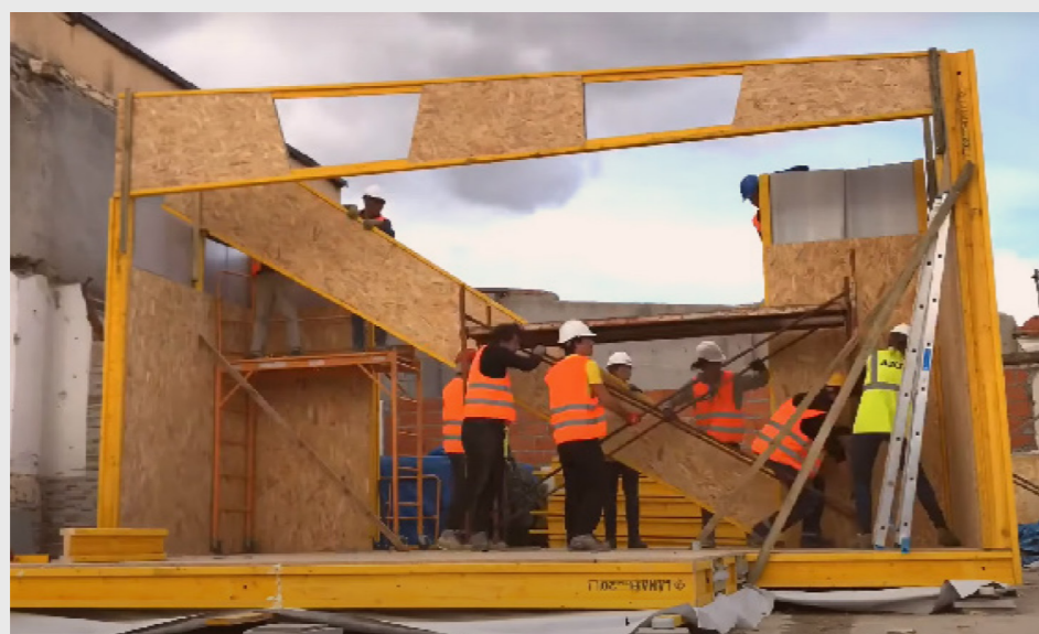
Proceso de montaje de las cerchas por parte de los vecinos de la Cañada Real. Recetas Urbanas, 2021.
