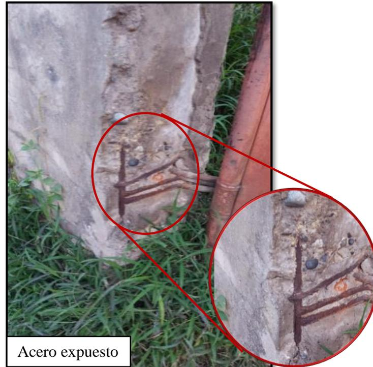
*Figura 2:* Acero de elemento estructural expuesto y visiblemente corroído
