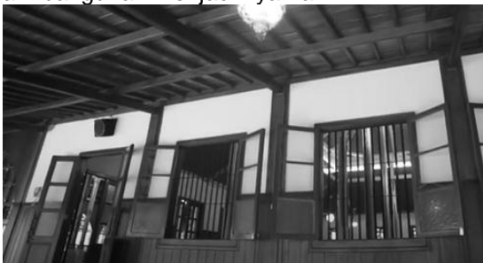
Gambar 1. Bukaan Pintu dan Jendela pada Bagian Utara
