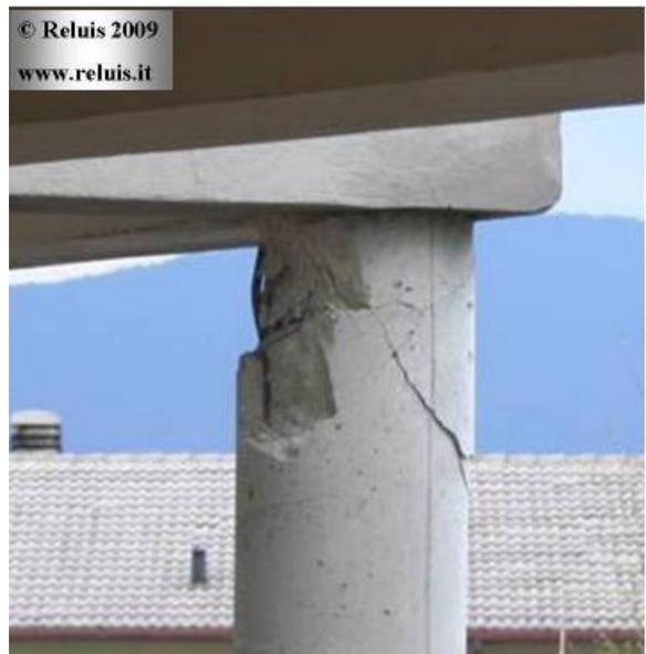
**Figura 4.3** Meccanismi di collasso di colonne per edifici in c.a. colpiti dal terremoto dell'Aquila, (fonte Reluis 2009) [32]
