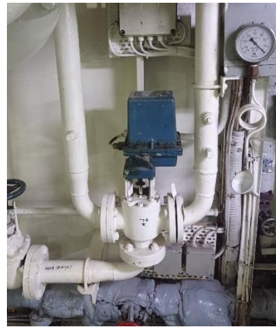
Figura 72 Válvula termostática evaporador
