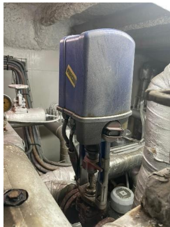
Figura 21 Válvula termostática de vapor 2
