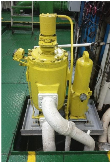
Figura 101 Filtro automático de aceite
