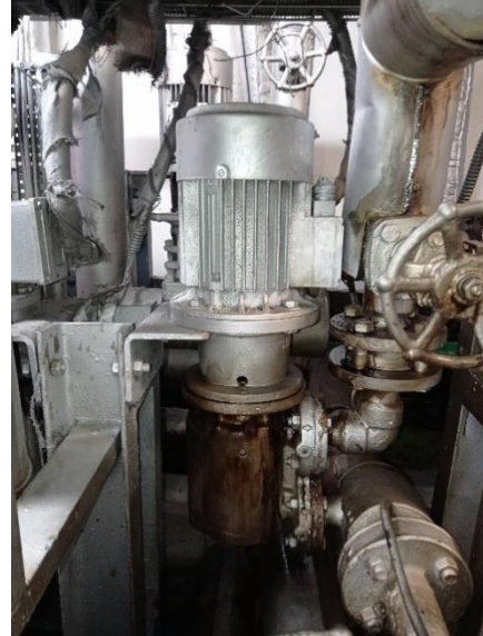
Figura 5 Bba de alimentación módulo comb.
