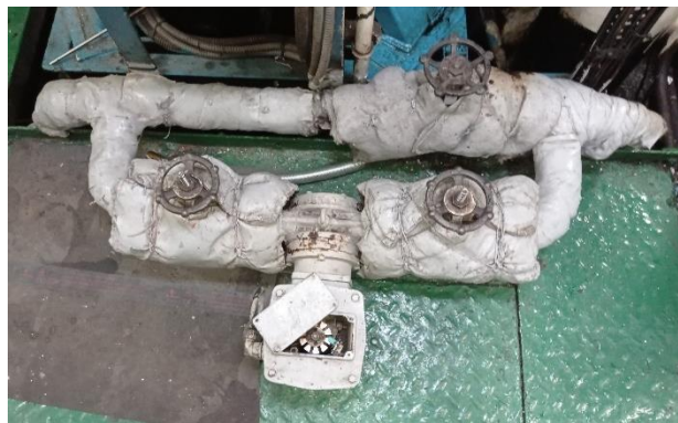
Figura 27 Caudalímetro
