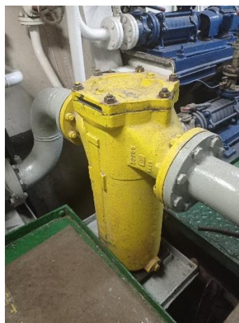
Figura 89 Filtro magnético 1
