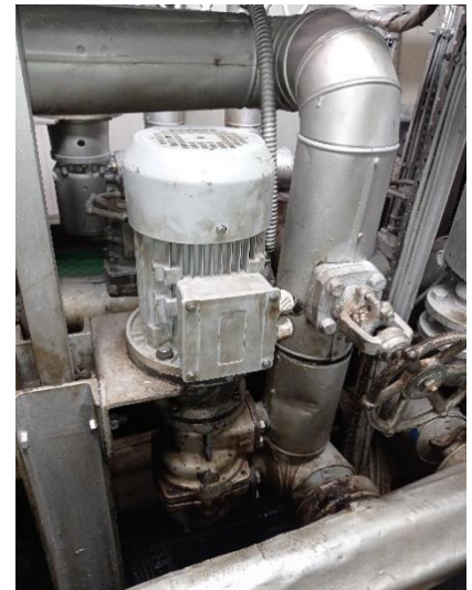
Figura 13 Bomba de circulación del módulo
