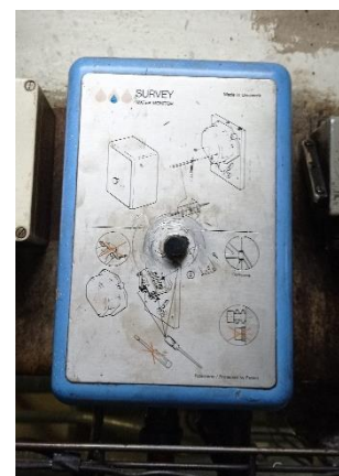
Figura 104 Detector de agua en aceite
