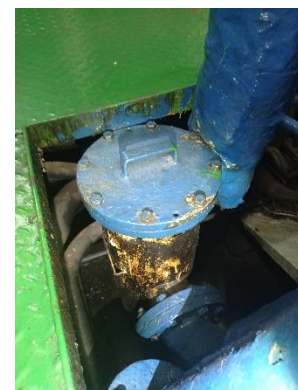
Figura 90 Filtro magnético 2
