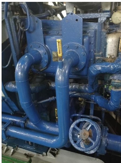
Figura 47 Enfriador de aire de carga
