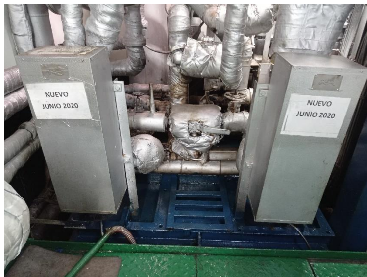
Figura 18 Calentador de placas del módulo
