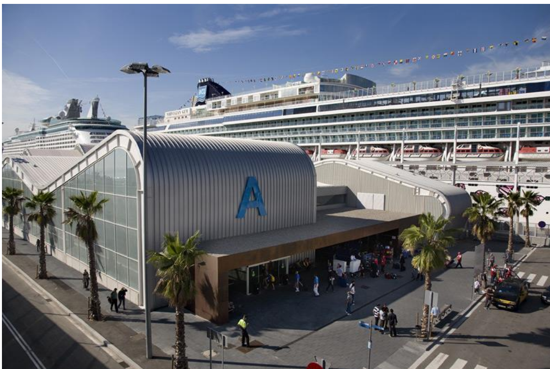
Figura 23: Terminal A del muelle Adossat en el Puerto de Barcelona. Fuente: Portal web del Puerto de Barcelona.
