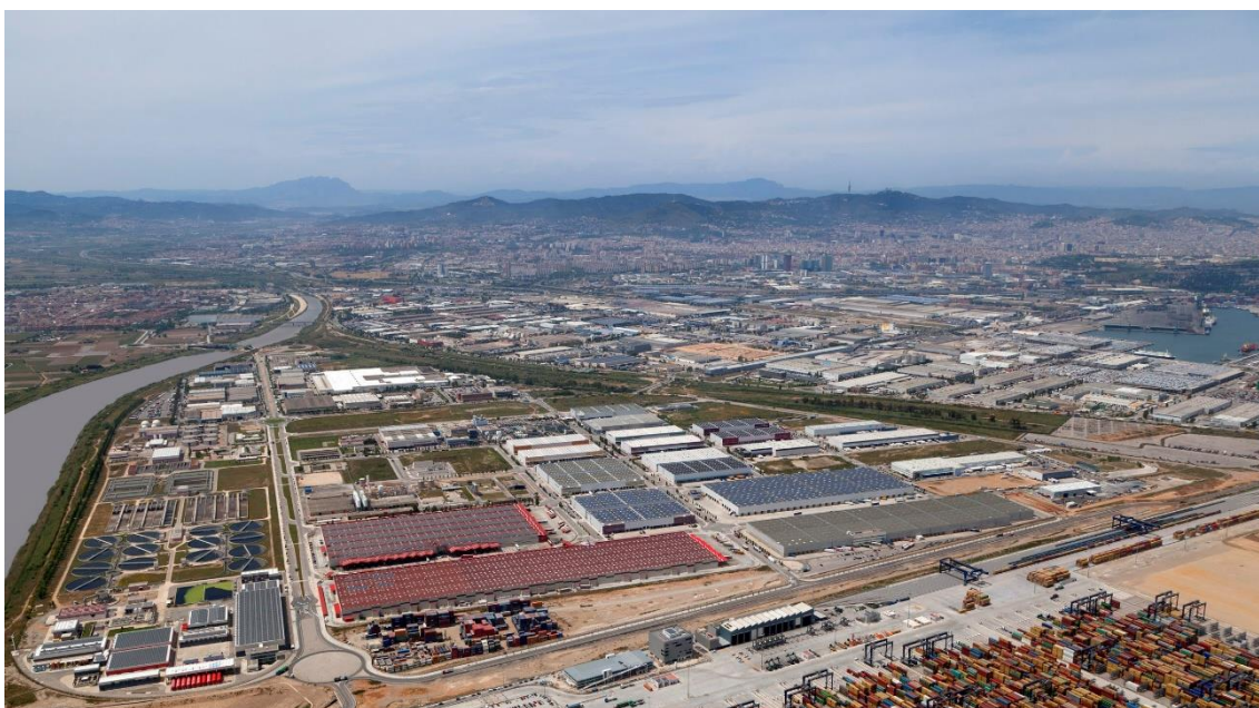
Figura 28: Zona de Actividades Logísticas (ZAL) del Puerto de Barcelona. Zona ZAL Port (Prat). Fuente: Portal web de ZAL Port.
