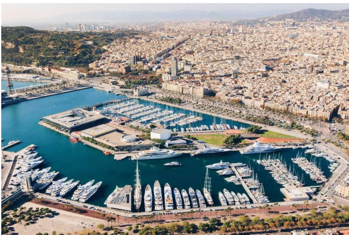
Figura 25: Port Vell de Barcelona. Fuente: Portal web Marina Port Vell.
