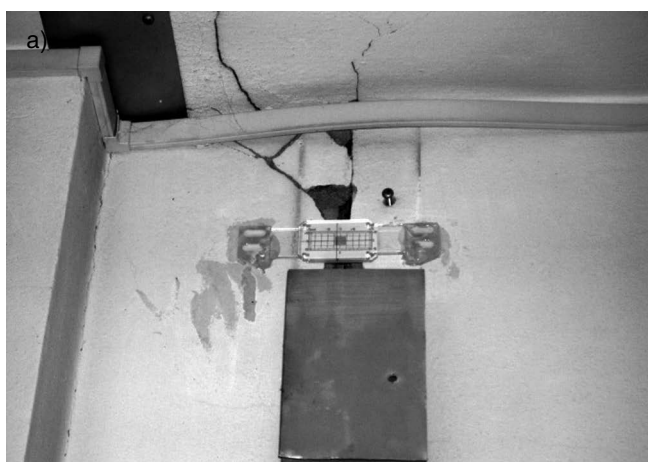
Fig. 7. Non structural damages: plaster cracks (a) and a pavement horizontal crack (b). Danni non strutturali: fessure nell'intonaco (a) e una fessura orizzontale nel pavimento (b).
