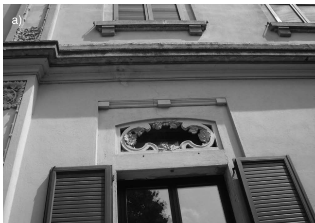
Fig. 9. Vertical cracks into architrave (a) and at the building base (b). Fessure verticali nell'architrave (a) e alla base dell'edificio (b).
