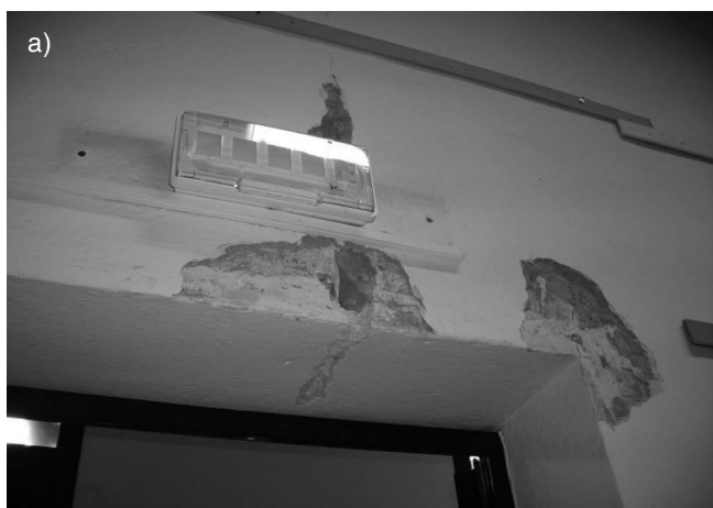
Fig. 10. Architrave (a) and wall-floor (b) cracks. Fessure nell'architrave (a) ed all'attacco parte-solaio (b).
