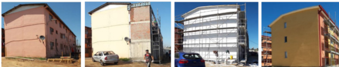
Imagen 17 Proceso de ampliación de conjunto Brisas del Mar
