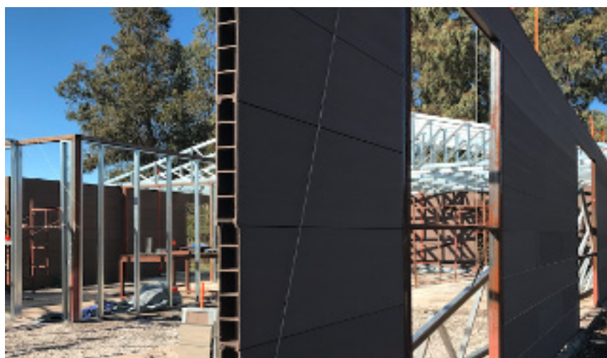
Imagen 5 Proceso de obra
