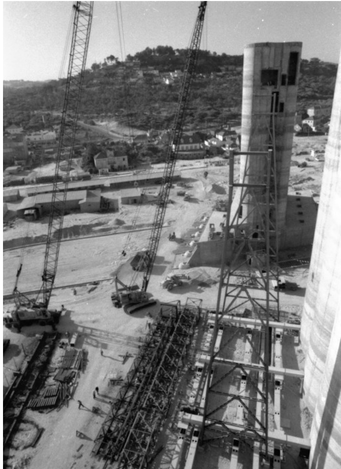
imagem 19 - construção dos silos da Silopor
