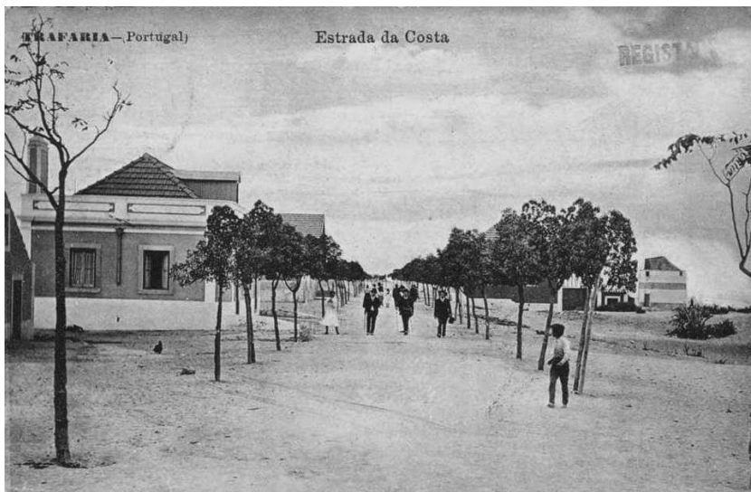
imagem 11 - estrada da costa
