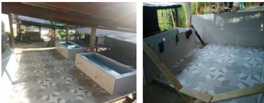
Gambar 3. Fasilitas rumah pengolahan ikan baru
