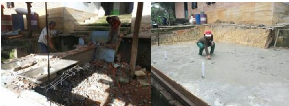
Gambar 2. Pembongkaran dan pengecoran rumah pengolahan ikan
