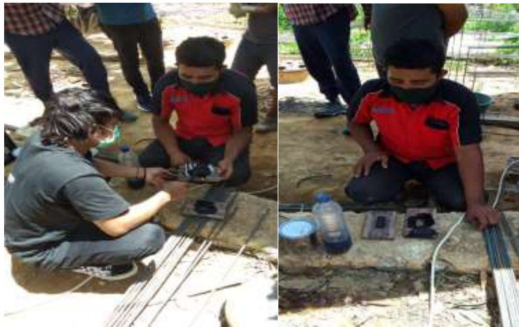
Gambar 7. Proses pelepasan cetakan
