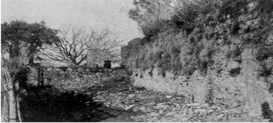
Fig. 3 – Construção identificada como o muro do Paço Real de Frielas (atualmente destruída). Montalvão Machado | Registo fotográfico | 1965. Proveniência: MACHADO, J.T. Montalvão – “Paço Real de Frielas”, p. 193.
