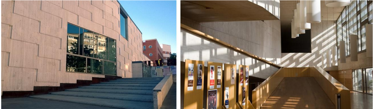
Fig. 4.1 Foto exterior del acceso principal al edificio (izq.) y foto interior del hall (dcha.)
