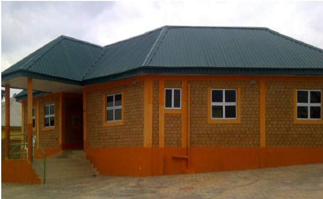
Figure 5. Construction of Heart Mega School using LIBs, Famese, Akure, Nigeria Source: Aghimien, Aghimien, 2015 [26].
