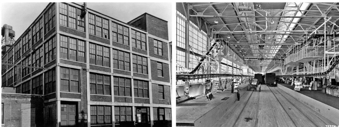
Слика 3.9 лево: Зграда Packard No. 10 (1903) у Детроиту (Detroit, Michigan, USA) аутор Алберт Кан (Albert Kahn); десно: Фордова фабрика (Ford Motor Company's Rouge Plant), изграђена 1917 у Дарборну (Dearborn, Michigan USA) ( Photo courtesy of the Albert Kahn Family of Companies ); извор: (Verens, 2011)
