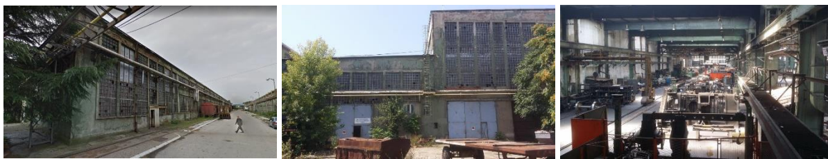
Слика 7.34 Фотографије актуелног стања испитиваног објекта зграде „Локомотива“ у оквиру комплекса МИН (извор: Google Street View; Развојна агенција Србије )
