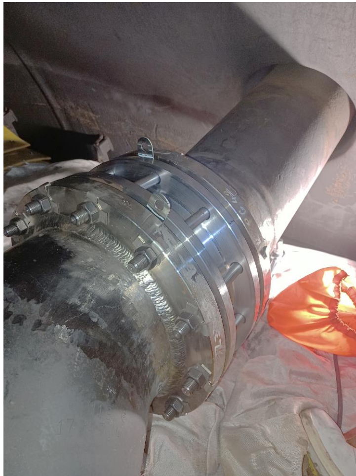
Obr. 3: Skutečné provedení po realizaci – PG42
