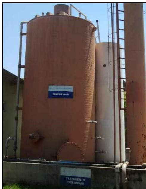
Figura 2.4: Reator UASB do CESA/UFRJ. Fonte: DHRIMA, 2012.
