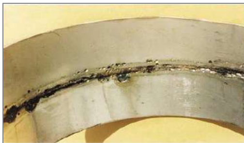
Figura II.12 - Tubulação de aço inox que sofreu corrosão em torno do cordão de solda (GENTIL, 2007).
