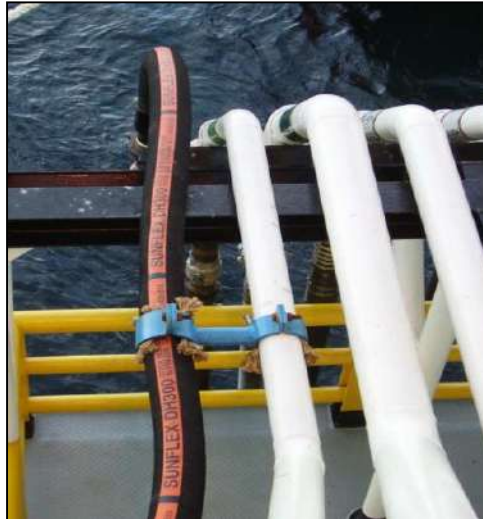
Figura 6.1- Downcomer . Fonte: Prestadora de serviço do setor de Oléo e Gás, 2011
