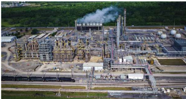
Figura 3.7 - Unidade de olefinas em Geismar onde ocorreu o acidente de 2013.
