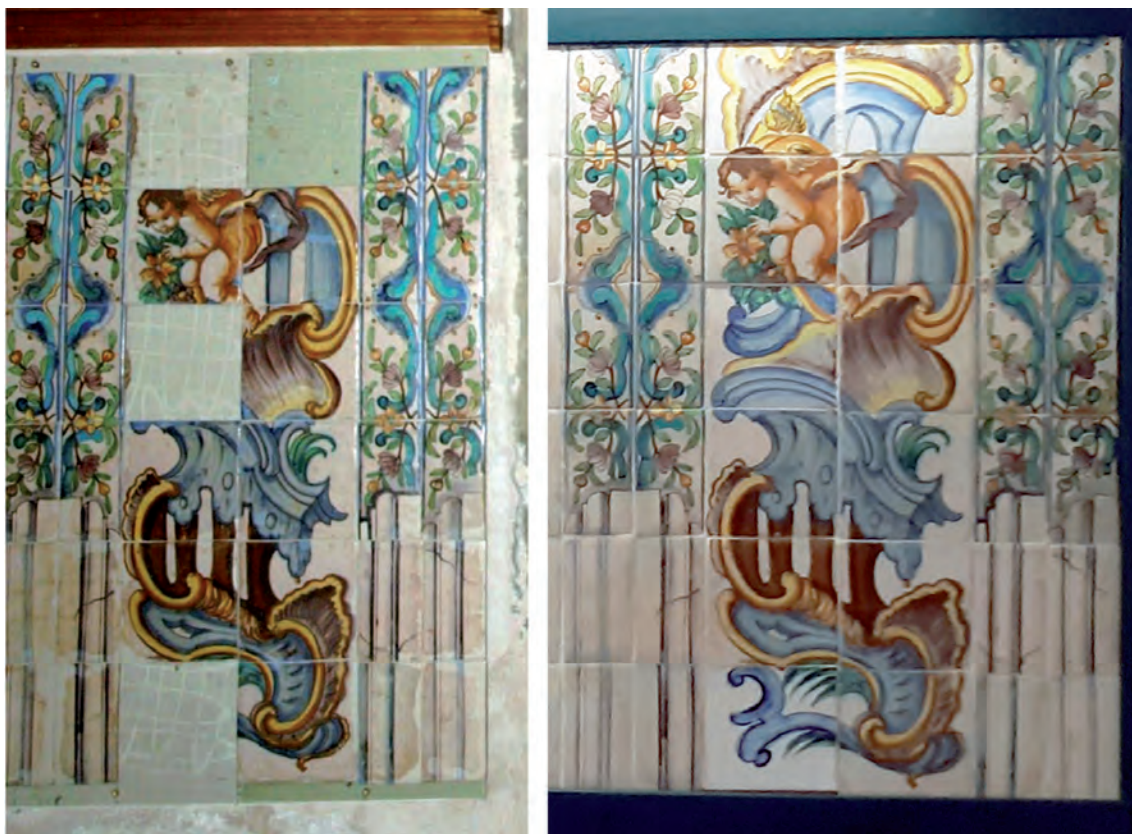
Fig. 16. Comparativa entre el panel restaurado sin las piezas de azulejería faltante, y ya completo en la intervención de 2021. Foto: Lucía Rueda Quero.
