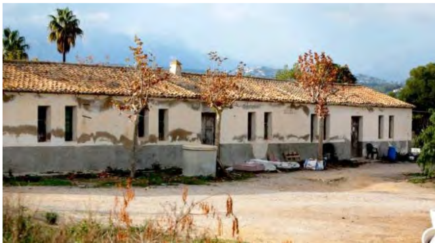
Fig. 6. Cuartel de El Albir (Alicante).
