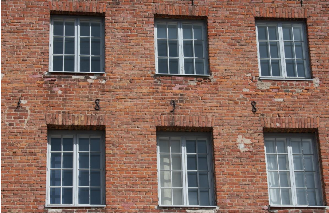
LIITE 1. Villatehtaan rakennusvuosi 1898 rakennuksen lännen puoleisella seinällä.
