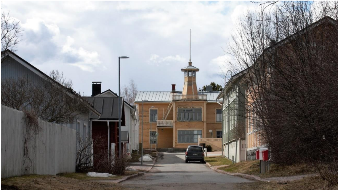
Kuva 9. Konepajan entinen konttorirakennus.
