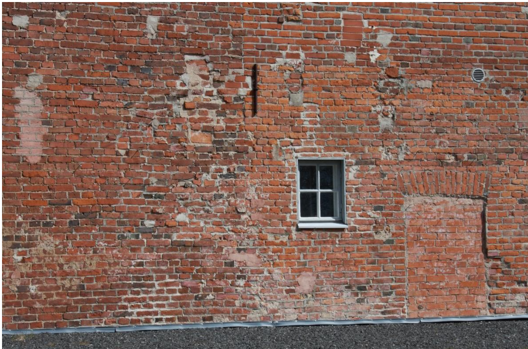
LIITE 2. Vanhan Villatehtaan seinässä näkyviä ajallisia kerroksia.
